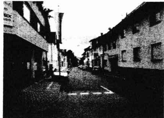
Foto 8: Bahnhofstraße - fehlende Gestaltung öffentlicher Raum
